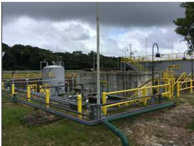
Figura 08 – Tanques de separação da salmoura do óleo diesel.
