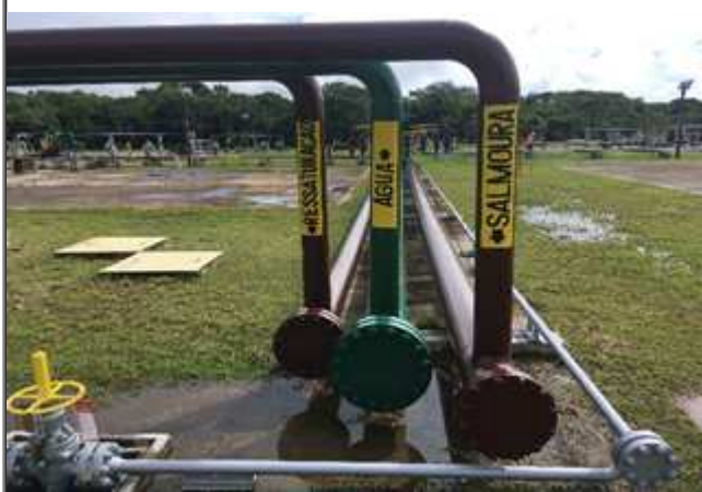
Figura 03 – Linhas de ressaturação, água e salmoura.
